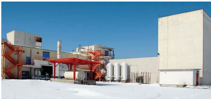
ΝΕΟ ΔΟΚΙΜΑΣΤΗΡΙΟ ΑΕΡΟΚΙΝΗΤΗΡΩΝ NEW ENGINE TEST FACILITY
