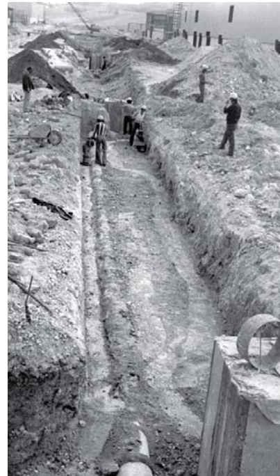
ΧΩΜΑΤΟΥΡΓΙΚΕΣ ΕΡΓΑΣΙΕΣ ΓΙΑ ΕΡΓΑ ΥΠΟΛΟΜΩΝ EARTHWORKS DURING THE CONSTRUCTION PHASE
