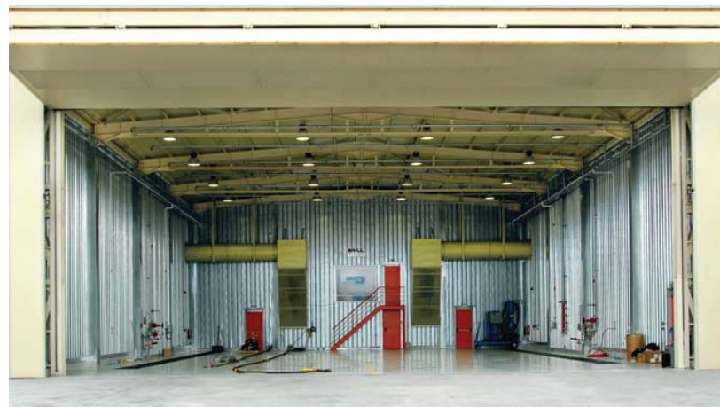
ΜΟΝΑΔΑ ΞΗΡΟΥ ΑΠΟΧΡΩΜΑΤΙΣΜΟΥ ΑΕΡΟΣΚΑΦΩΝ THE DRY PAINT STRIPPING FACILITY
